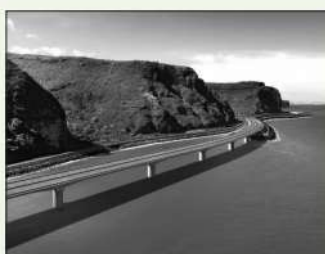
Une nouvelle route littorale en construction (voir fiche 8).
