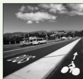
Des voies de bus et des pistes cyclables à Saint-Philippe.
