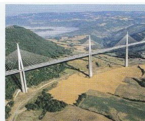
Le viaduc de Millau
