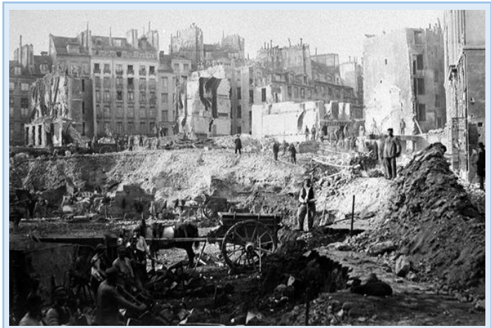
Doc 7 : Le début des travaux en 1853
